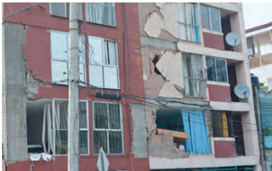
Muros no estructurales (Ing. Francisco García Jarque)
