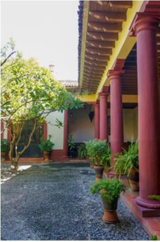
Figura 19. Imagen de un corredor del patio principal en que se observan las columnas dóricas de concreto que carga una trabe, también de concreto. Fuente: fotografía de la autora.
