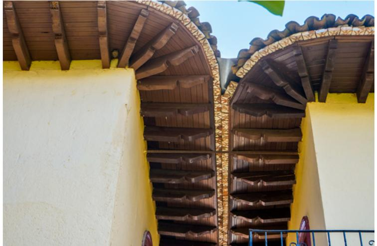
Figura 20. Detalle de la terminación del lecho inferior de los aleros, con el cerramiento curvo en esquina, y las vigas, tapa de ladrillo decorado y teja que forman la estructura. Fuente: fotografía de la autora.
